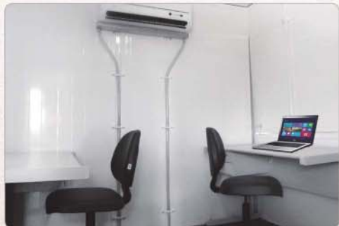
▶ Escritório com ar condicionado. ▶ Tomadas por energia solar.
